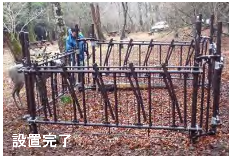
試作 2 号機の設置状況
