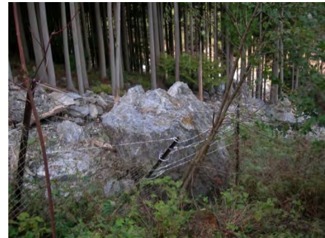
溪流の氾濫により大岩が移動し、一部損壊したパッチディフェンス。シカは岩を足場に侵入したと考えられる。
