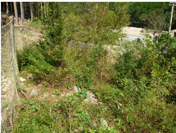
事業地 3 (平成 21 年施工)
