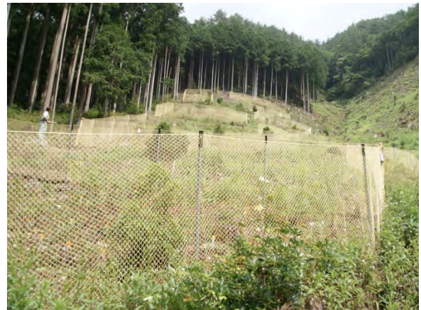
事業地 2 (平成 21 年施工)
