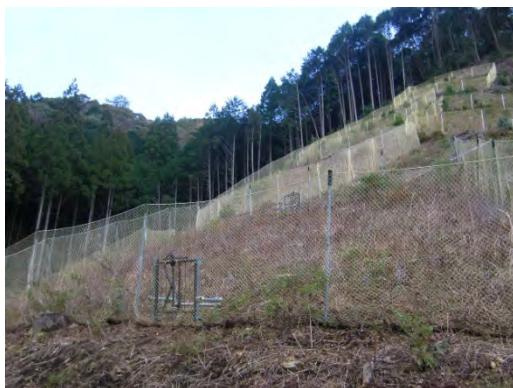
写真6 広葉樹植栽地設置状況
