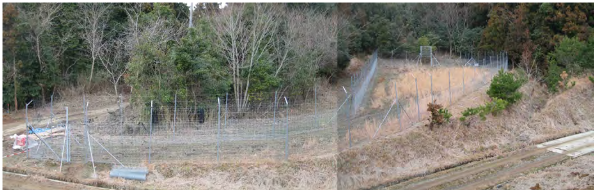
図 2-3 固定捕獲柵遠景
