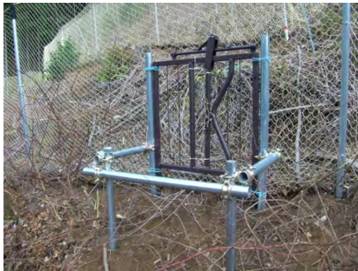
写真8 上部設置状況
