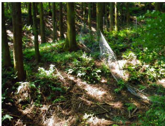
土砂で壊れた柵
