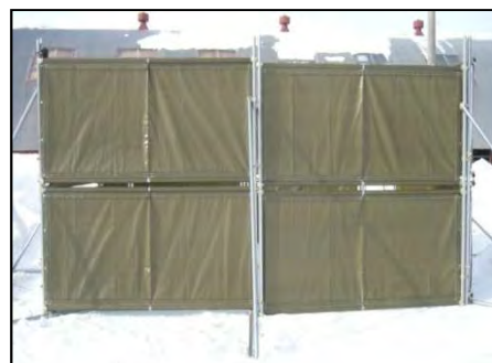
写真Ⅱ-3-6 シートを使った簡易パネル壁面
