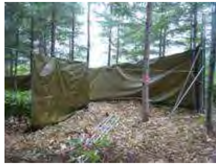
写真Ⅱ-3-2 シートの状況
