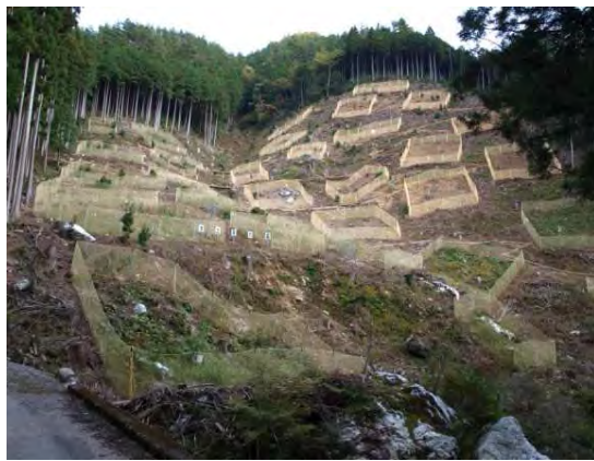
写真Ⅱ-2-1 広葉樹植栽地設置状況
