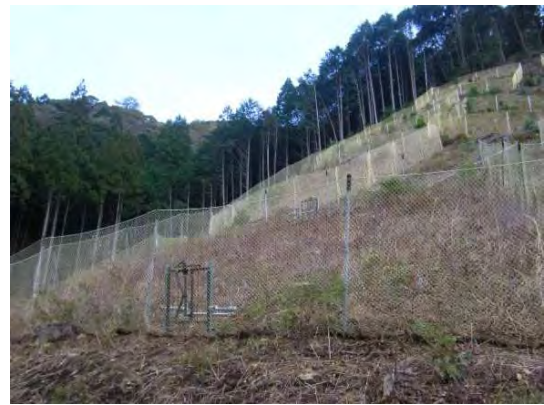
写真Ⅱ-2-2 広葉樹植栽地設置状況
