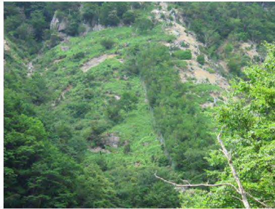
写真Ⅲ-3-3. 設置済みの植生保護柵
