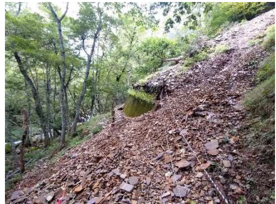
写真4. 土砂崩れした斜面
